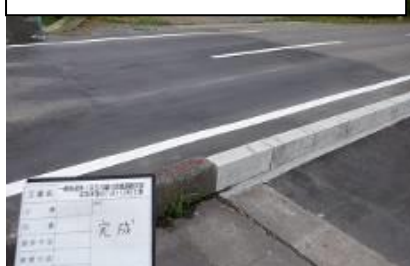
復旧完了【県道角ノ浜玉川線】
