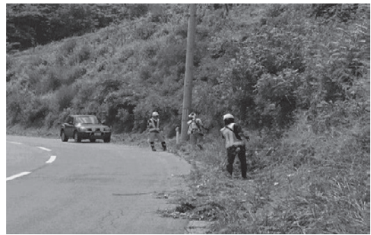
集落住民による道路の草刈り作業
