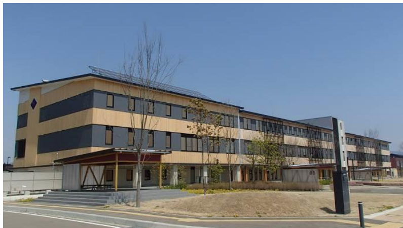
国内最大級の木造3階建て役場庁舎（紫波町）
