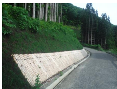
土木施設での木材利用
