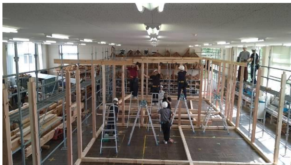
仮組作業の様子
