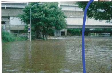
②平成14年7月11日浸水状況
