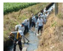
水路の泥上げ
