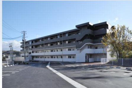
黒沢尻団地（北上市） 令和元年11月完成
