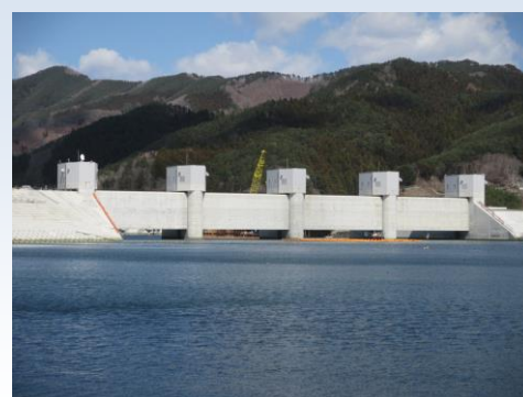
大槌川水門（令和2年2月完成）
