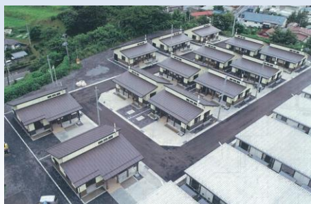
構井田団地（一関市） 令和元年8月完成
