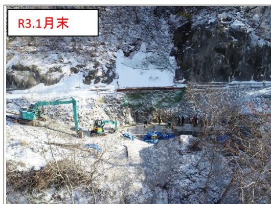
施工状況 谷側上空より(撮影:R3.1月末)
