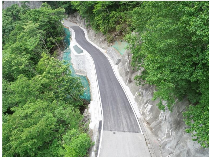
完成写真(釜石側上空より)
