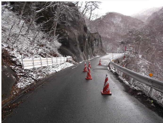
着手前写真(遠野側より)
