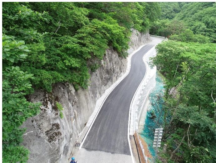
完成写真(遠野側上空より)
