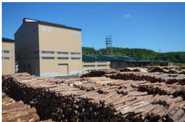
【県内の木質バイオマス発電施設】
