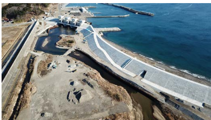
▲野田地区海岸防潮堤
