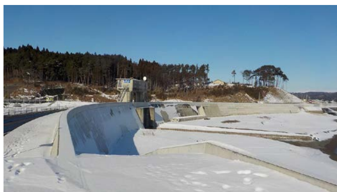
▲米田地区海岸防潮堤
