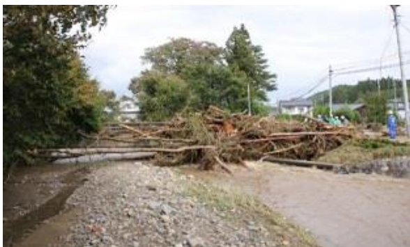
令和元年東日本台風による被害（久慈市）
