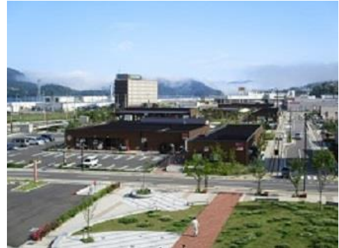
津波防災拠点市街地形成施設（大船渡市）
