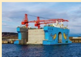
ケーソンの据付が進む久慈港湾口防波堤。津波の被害を最小限にするほか、湾内の波を穏やかにする効果も
