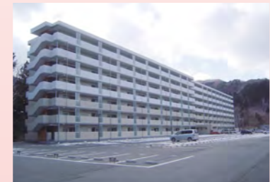
災害公営住宅 沿岸地域では、県や市町村が5,550戸を整備。写真は釜石市平田アパート。
