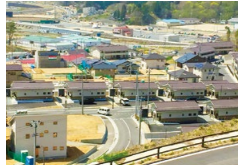
まちびらき後の田老地区 かさ上げや高台移転した土地で、住宅などの建設が進む。
