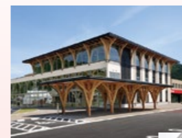
おしゃっち開館 町中心部に誕生した、図書館や交流施設を備えた複合施設。地域の憩いの場に。 写真提供:おしゃっち
