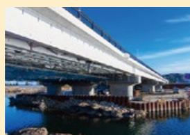
整備が進む三陸沿岸道路の久慈大橋。3月中の開通を目指し、工事は急ピッチ
