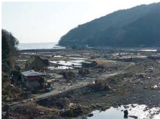
被災状況 (H23.3)
