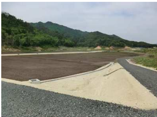
復旧状況 (H27.5)
