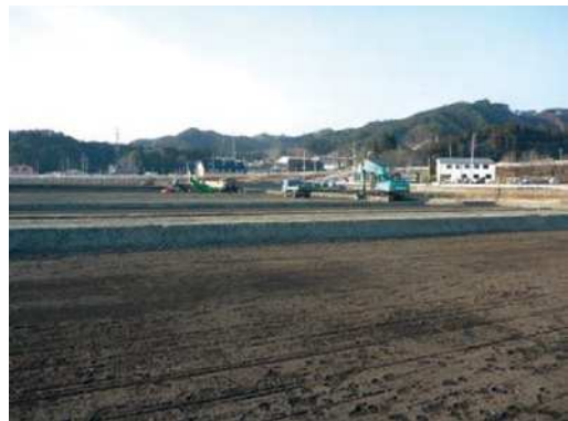
施工状況 (H28.2)
