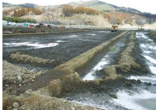
施工状況 (H26.2)
