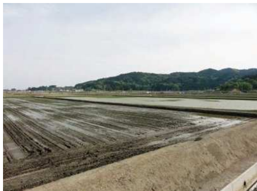
復旧状況 (H26.5)
