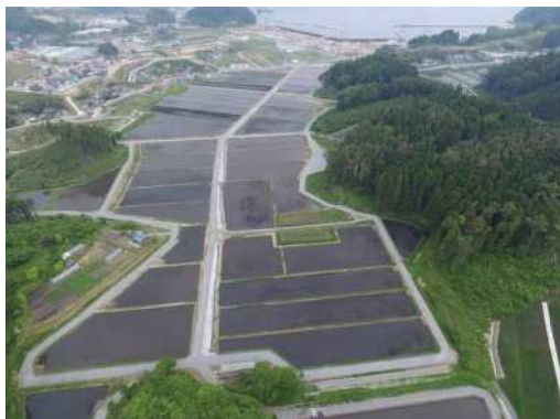
復旧状況_羽根穴工区
