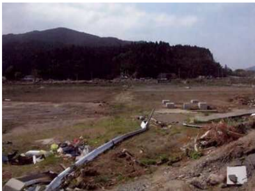
被災状況 (H23.3)
