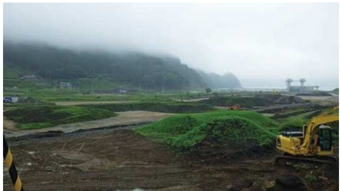
施工状況 (H25.7)
