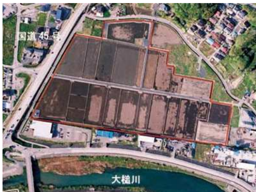
復旧状況 (H28.5)
