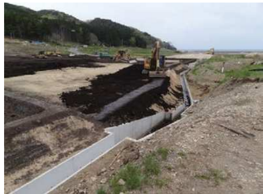
施工状況 (H25.4)
