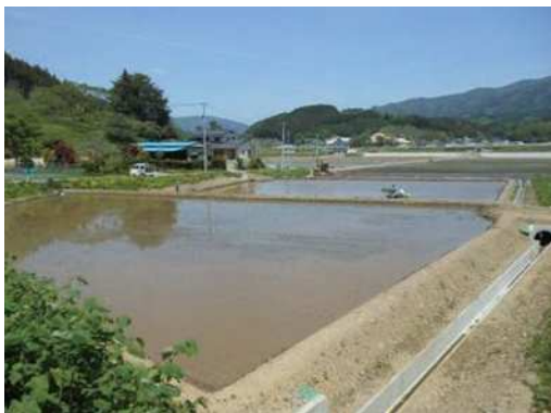
復旧状況 (H26.5)
