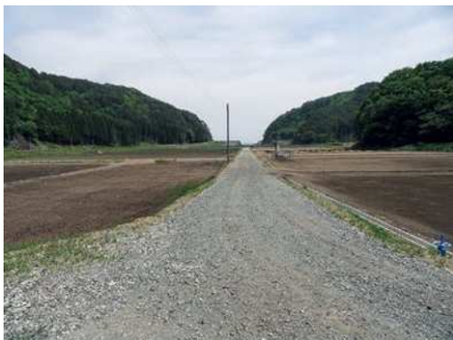
復旧状況 (H27.5)
