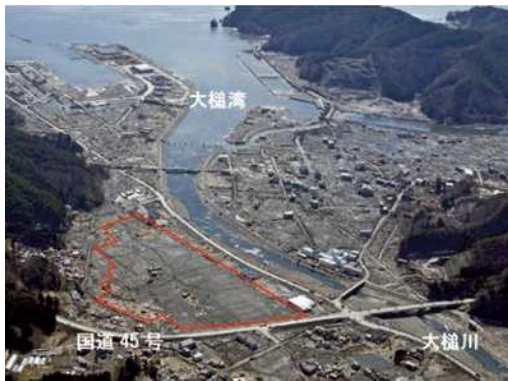
被災状況 (H23.3)
