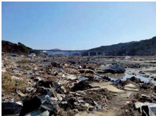
被災状況 (H23.3)
