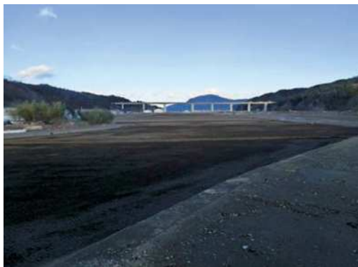
復旧状況 (H27.1)
