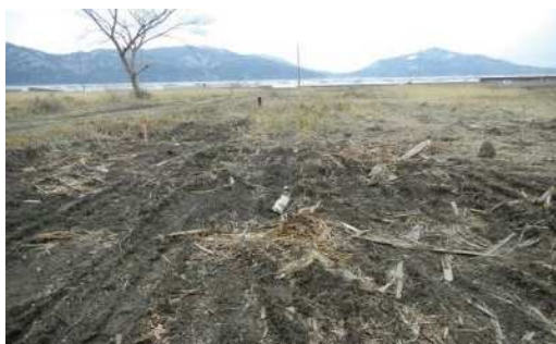
被災状況 (H23.3)
