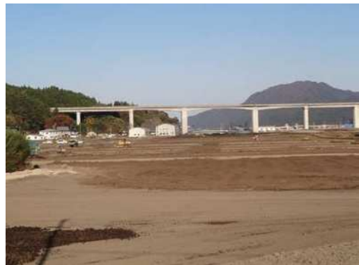
施工状況 (H26.10)
