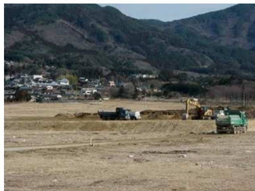
施工状況 (H25.3)
