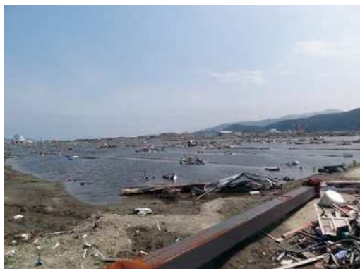
被災状況 (H23.6)
