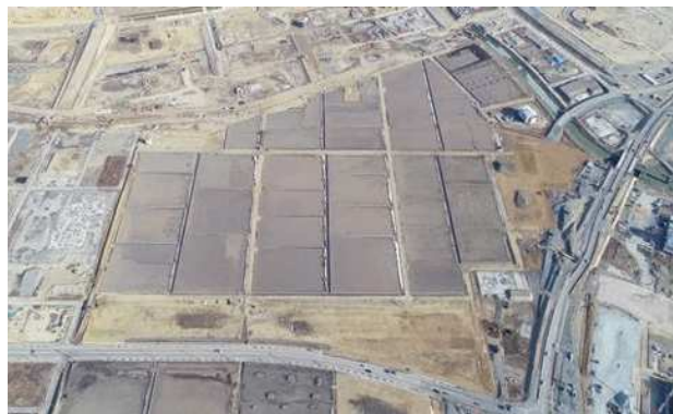
復旧状況 (H31.1)
