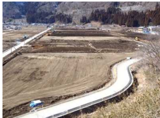
施工状況 (H25.4)
