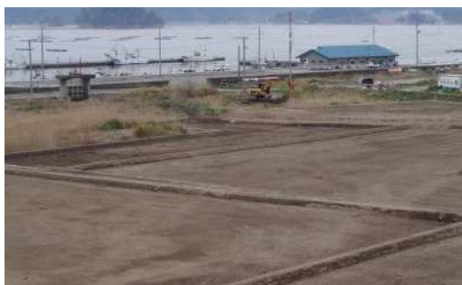
復旧状況 (H27.1)
