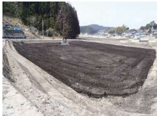
施工状況_平畑工区
