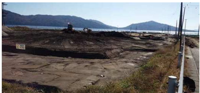
施工状況 (H26.10)
