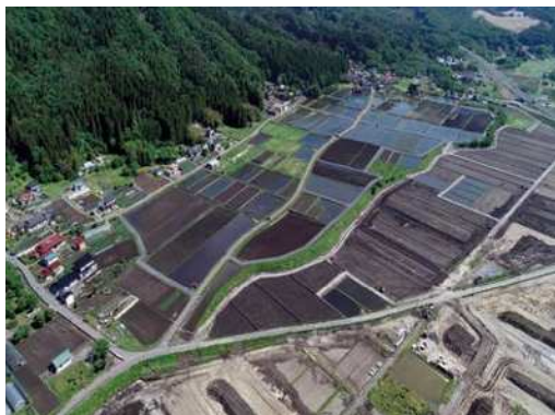
復旧状況 (H30.4)
