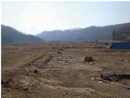
被災状況 (H23.3)
