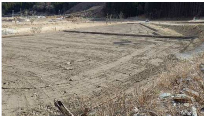
復旧状況 (H25.3)
