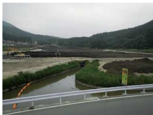
施工状況 (H27.6)
