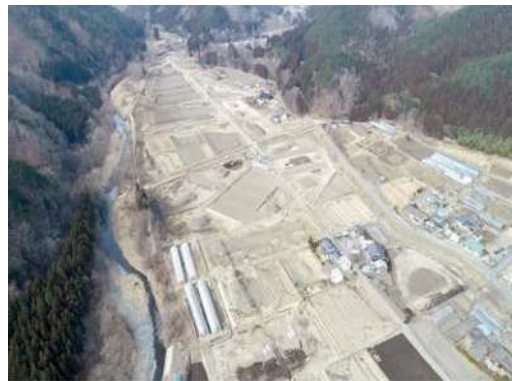
施工状況 (H30.2)
