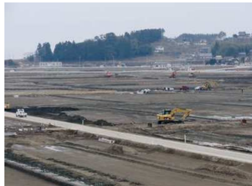
施工状況 (H26.1)
