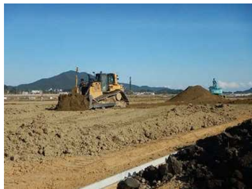
施工状況 (H30.10)
