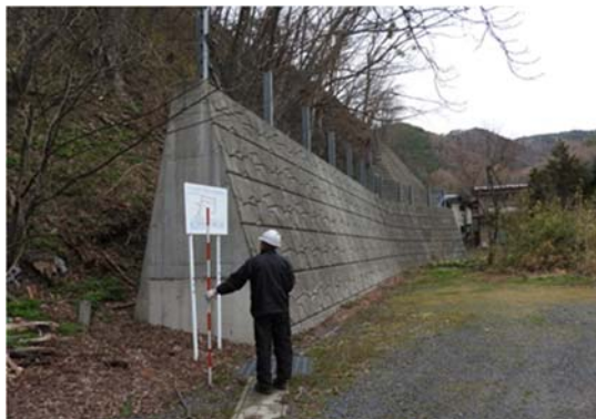
図 4 急傾斜地崩壊防止施設（擁壁工）
