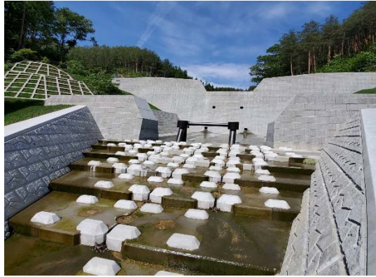
図 2 砂防設備（砂防堰堤）
