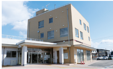
保健センター外観（写真提供：野田村）
