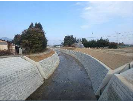
完成区間状況 (令和3年3月)
