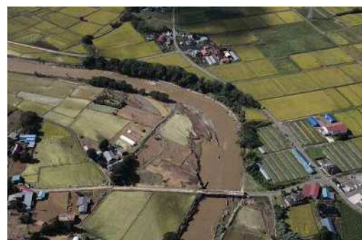
被災状況（平成 25 年 9 月 松川）
