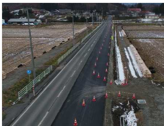
国道 456 号方向から県道改良部望む（令和 6 年 12 月撮影）
