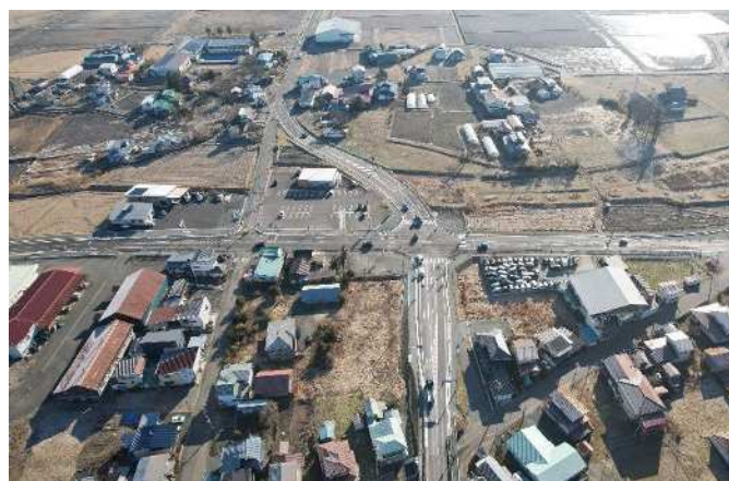
掛け違い交差点解消状況を望む（令和 6 年 2 月撮影）
