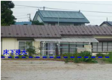
浸水被害状況 (平成25年8月)
