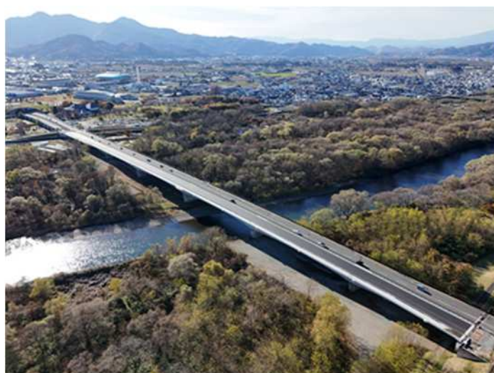
上部工施工状況（令和 6 年 11 月撮影）
