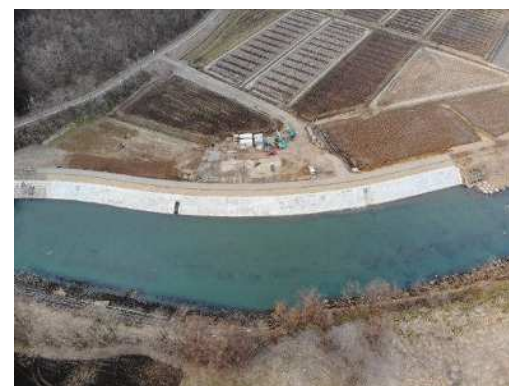
令和 5 年度松川整備状況（令和 6 年 3 月）
