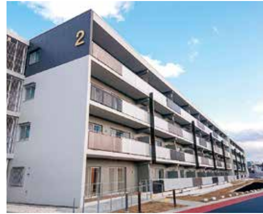
災害公営住宅「南青山アパート(盛岡市)」(令和2年12月完成)
