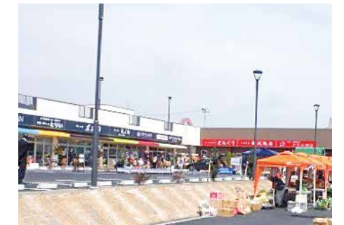
グループ補助金により再開した商業施設 【大船渡市】
