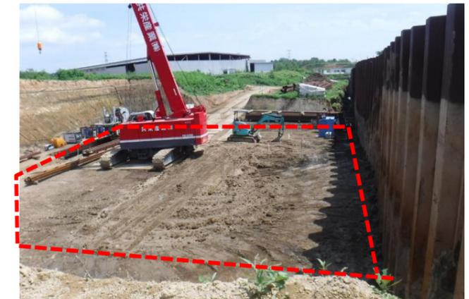
図8 イ-24 及び1号集水井掘削除去の準備工 (点線は掘削予定範囲)
