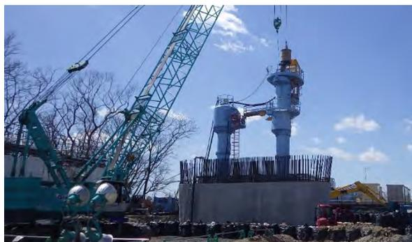
ケーソンによる沈下掘削
