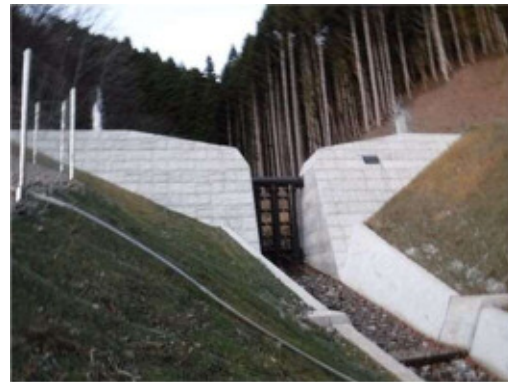
砂防堰堤完成事例
