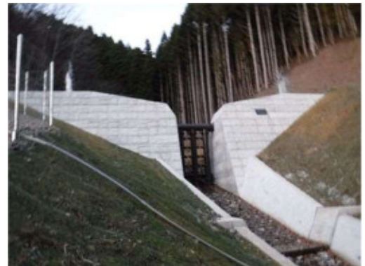
砂防堰堤完成事例
