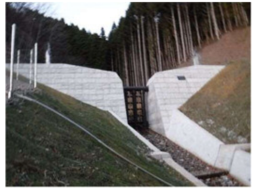
砂防堰堤完成事例
