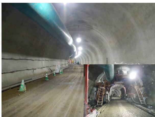
〈 覆工コンクリート打設完了 〉
