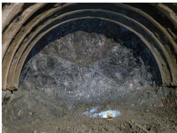
〈 切羽（きりは）の状況 〉
