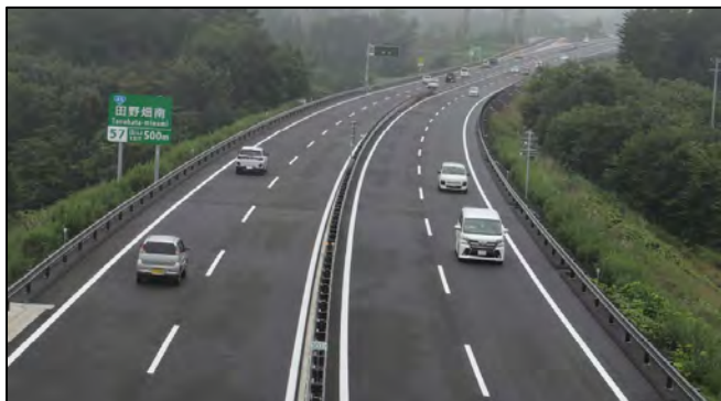
交通開放状況（本線）
