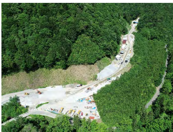
〈 道路改良区間の状況 〉
