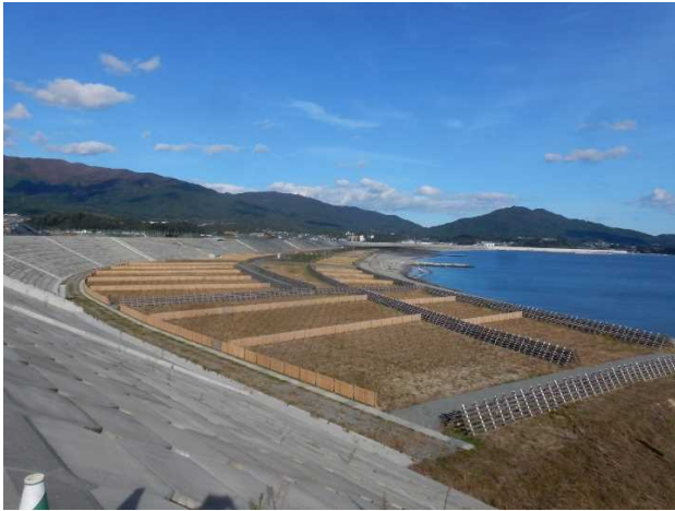
写真-4 防風柵設置状況
