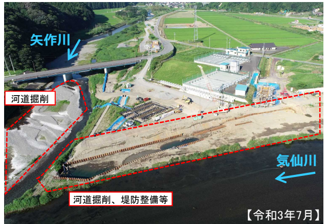
【河道掘削、堤防整備（気仙川） 越戸内地区】
