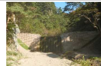
【治山：溪間工（久慈市）】
