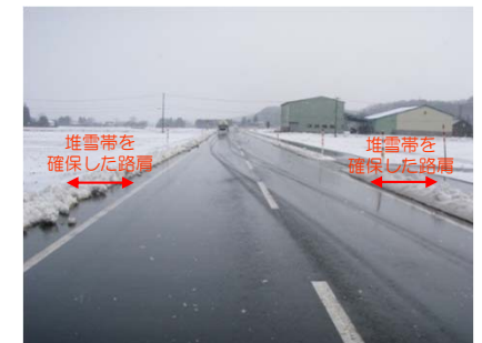
▲ 堆雪帯を確保した道路構造事例
