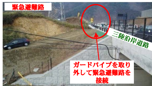
▲東日本大震災での緊急対応事例（山田道路）
