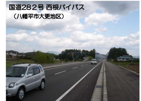
▲あい路区間の整備事例（高規格道路を補完する道路）
