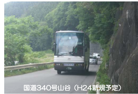
▲ 復興道路を補完する道路のあい路事例
