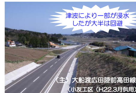
▲津波浸水を回避した道路整備事例
