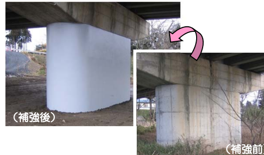
▲橋梁耐震補強の推進
