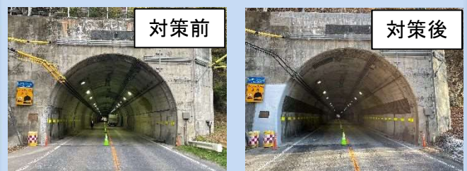
▲ (国) 106号 大峠トンネル (宮古市)
