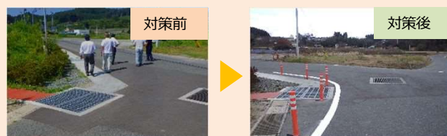
▲（主）大船渡広田陸前高田線 広田工区（陸前高田市） 歩車分離による巻き込み防止対策
