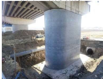
▲ (主) 一関北上線 「中里橋工区」(一関市)
