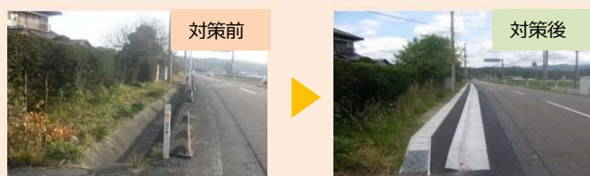
▲国道456号 江刺大日工区（奥州市） 側溝蓋掛けによる歩行空間の確保
