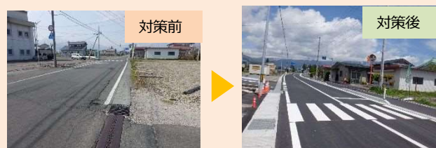
▲（一）雫石東八幡平線 長山工区（雫石町） 歩道設置
