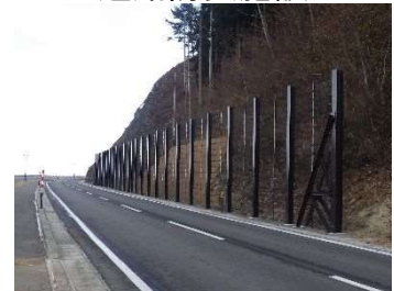
▲ (主) 岩泉平井賀普代線 「黒崎～明神工区」(普代村)
