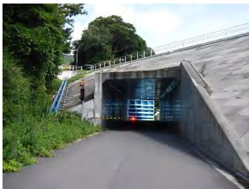
小白浜陸閘 閉鎖の様子
