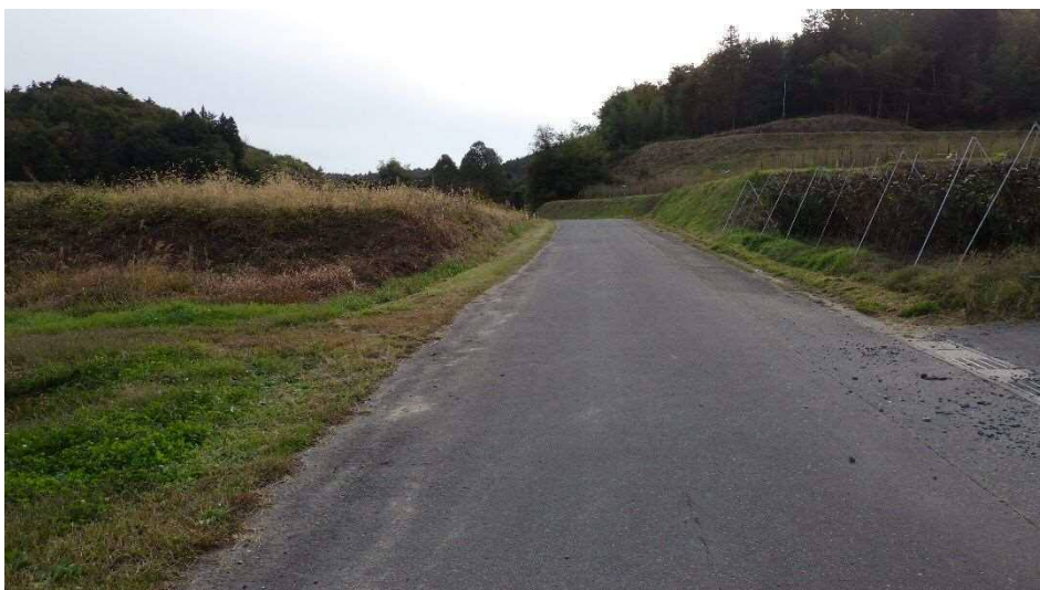
写真 7. 2-3 No. 3 地点の地表面の状況
