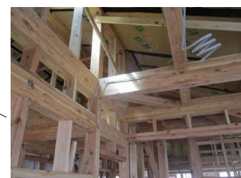
柱、梁などに県産木材を使用
