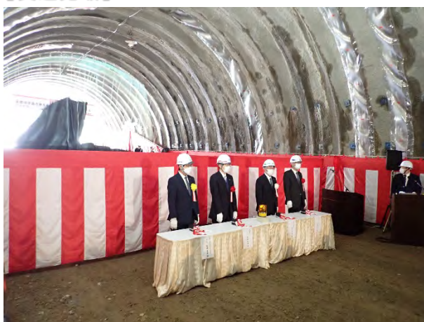
発破ボタンを押してついに貫通！ トンネル内に光が差し込みました
