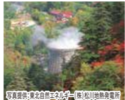
写真提供:東北自然エネルギー(株)松川地熱発電所
