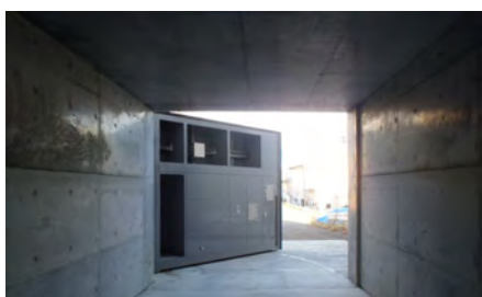
写真2 小白浜2号陸閘 (開放中)
