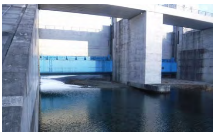
写真3 下荒川農地水門 (開放後)
