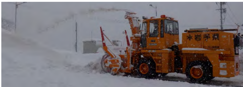
【除雪訓練状況】グレーダにて除雪
