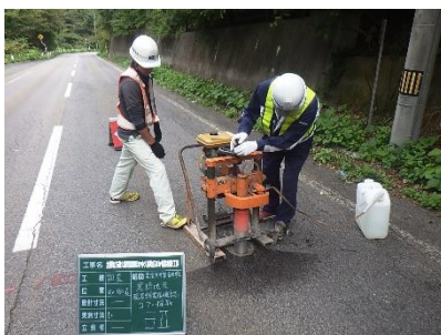
▲ 現場作業の様子
