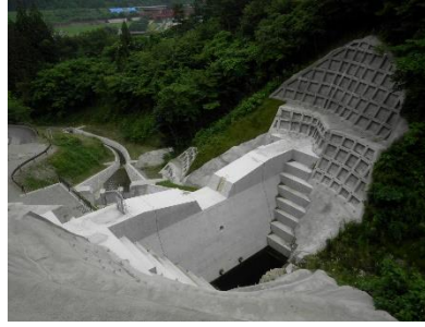
▲ 完成した堰堤の写真
