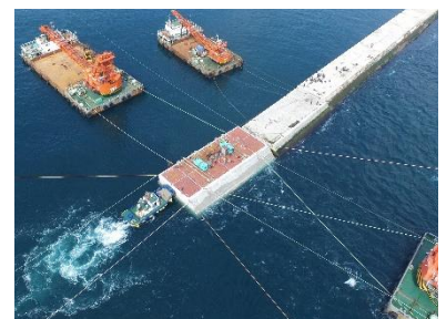
▲ 防波堤の据付。GPSを使いミリ単位で調整する。
