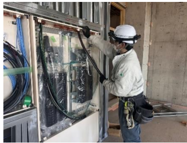
▲ 配線作業に集中！
