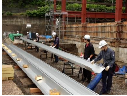
▲ 屋根に上げる銅板の準備
