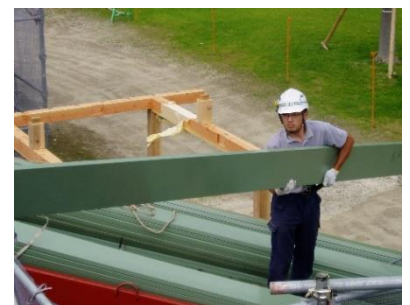
▲ 屋根材の搬入作業
