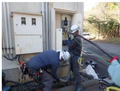
▲ケーブル通線作業状況
