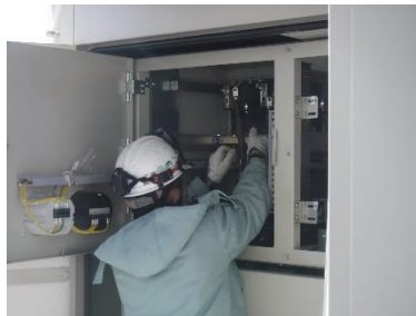
▲非常用発電機へのケーブル 接続状況を確認している作業
