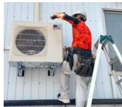
▲ 室外機に冷媒管を 接続する作業
