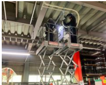
▲ ドレン配管作業
