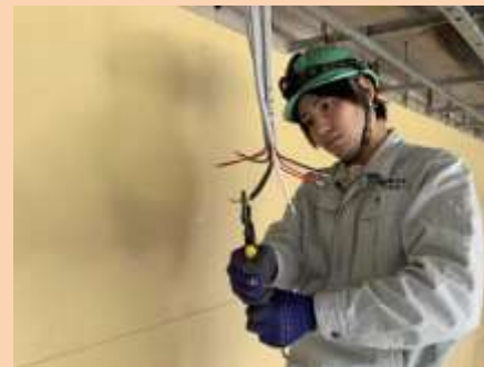
▲配線の接続作業
