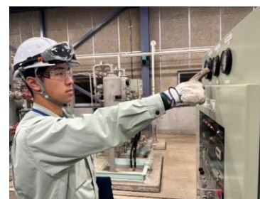
▲現場にて設備運転中
