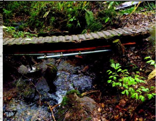
補修された木道
