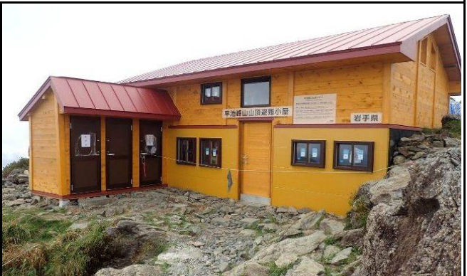
外見はほぼ完成していた山頂避難小屋
