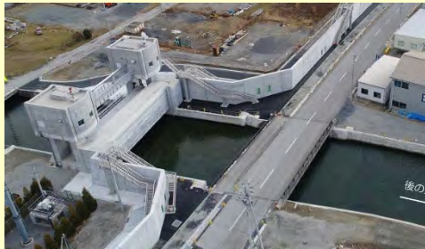
▲跡浜海岸防潮堤(大船渡市):R3.12完成
