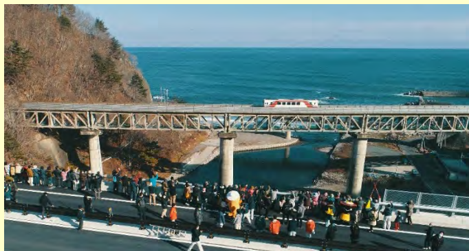
▲ 三陸沿岸道路全線開通イベント（下安家大橋）
