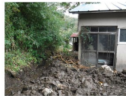
流出した土石が家屋まで到達し、家屋の一部が埋ましている
