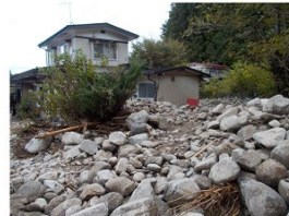
沢から流出した巨石が人家まで到達している
