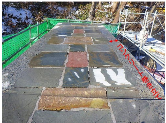
[橋脚上部カット後の状況]
